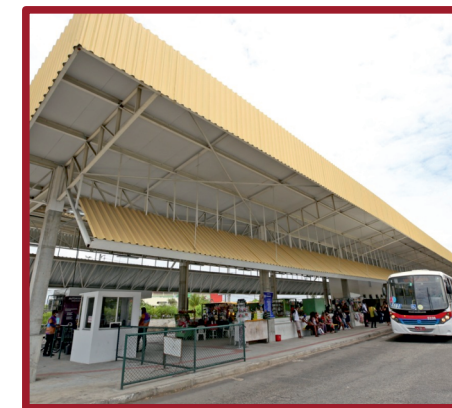
Foram realizadas melhorias estruturais em três dos seis terminais de integração existentes
